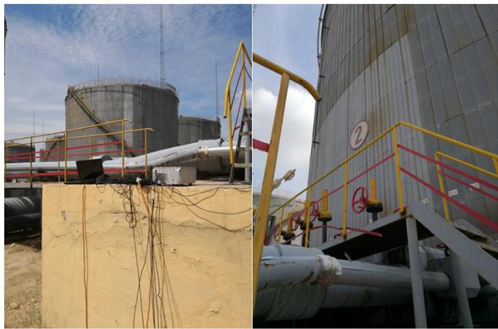
储罐类型为外拱顶储罐，储罐容积为 10000 立方米，直径 27.75 米，有效高度 14.8 米，存储介质为原油，安全液位 12.5 米，检测初始液位 17.8 米，罐壁外涂有防腐漆，有保温板及金属铁皮护板。
