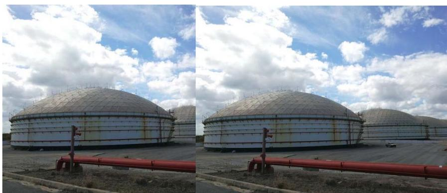
2017年3月6日至3月12日，在古巴马坦萨斯港口油库罐区，依照中国机械工业标准《JB/T 10764—2007 常压金属储罐声发射检测及评价方法》进行检测。
