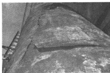
图4 外层板开裂
